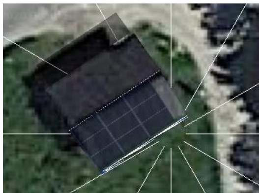
Abbildung 5-3: PV-Anlage auf dem Pumpwerk Piesenkam.
