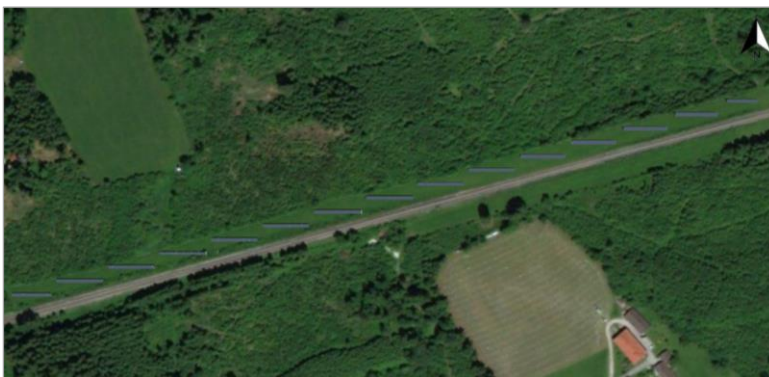
Abbildung 5-5: PV-Freiflächenanlage nördlich der Bahnlinie für das Pumpwerk Fuchsloch.
